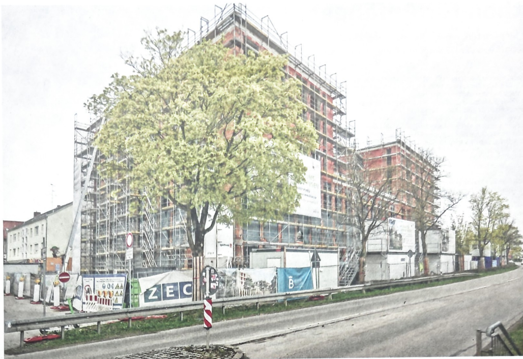
Ein multifunktionaler Gebäudekomplex mit Büros, Schulungsräumen sowie 38 Eigentums- und Mietwohnungen entsteht derzeit an der Landsberger Straße in Germering. Anfang Dezember dieses Jahres soll das Gebäude bezugsfertig sein. FOTO: NIELS P. JØRGENSEN
